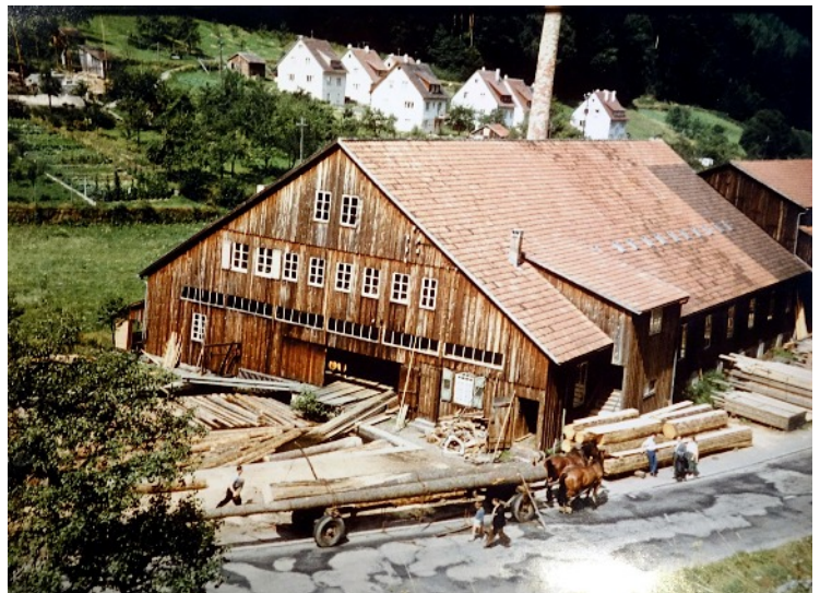
So stand das Sägewerk mit dem 35 Meter hohen Kamin vor dem Brand von 1973 da. Bilder: Digitalarchiv Schabert
