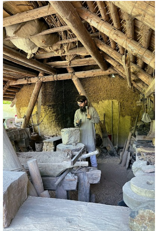
Ein Steinmetz ist im Campus Galli bei der Arbeit zu sehen; erkennbar sind im Innern des Daches die mit Holznägeln gesicherten hölzernen Dachschindeln. Bild: Karla Arp
