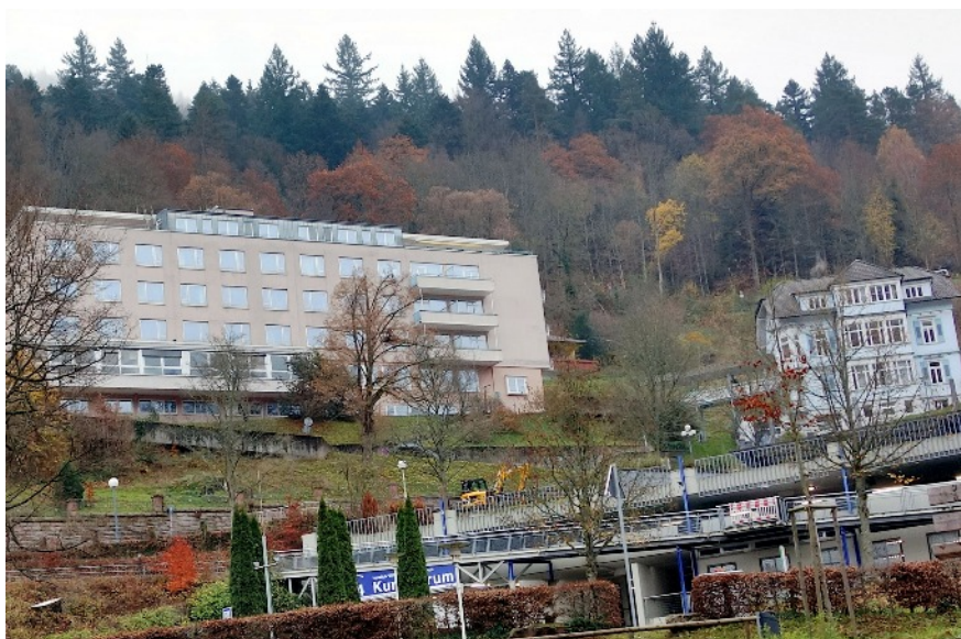
Über dem Parkhaus Kurzentrum und der Olgastraße ragt die ehemalige, als 80-Betten-Haus im Mai 1967 eingeweihte Baetzner-Klinik stattlich in die Höhe, die seit Jahren leer steht. Seine Anfänge hatte das Krankenhaus 1951 in dem grauen Gebäude rechts unterhalb genommen.
