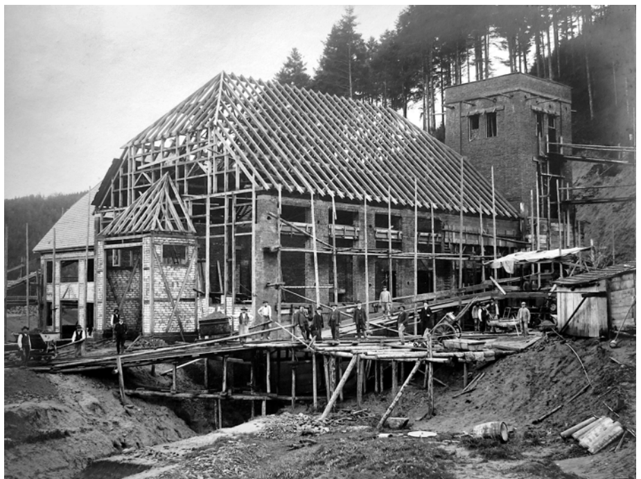
Im Bau ist vor etwa 110 Jahren das bis heute Strom erzeugende Wasserkraftwerk im Teinachtal, das von einem Gemeindeverband errichtet wurde, zu dessen Gruppe von 24 Gründer-Gemeinden auch das damals von Schultheiß Johann Georg Mast geführte Neuweiler gehörte.
