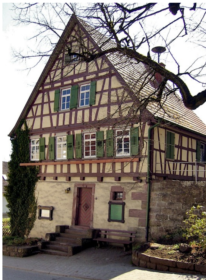
Im damaligen Rathaus, dem heutigen, wegen notwendiger Bauarbeiten geschlossenen Heimatmuseum Neuweiler wurde 1900 die Leistung von Schultheiß Johann Georg Strehler gewürdigt.
