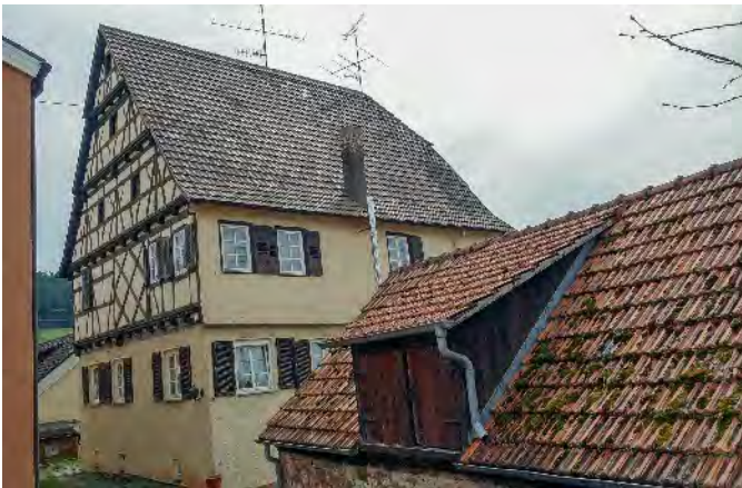
Das große, gepflegte Fachwerkhaus trug früher, als die Häuser noch nicht nach Straßen benannt waren, die Nummer 1 und ist laut Ortsvorsteher Oskar Huber mit der Kirche zusammen wohl das älteste Gebäude im Ort.
