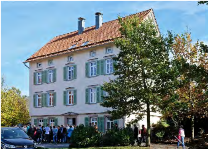
Blick auf das Nazarenerhaus aus Richtung der Durchgangsstraße
