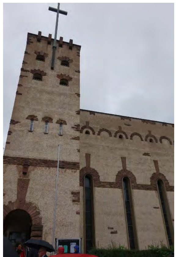
Der Eingangsbereich der Neuenbürger katholischen Kirche und die hohen Glasfenster in der Wand zur Straße im Kirchenschiff.
