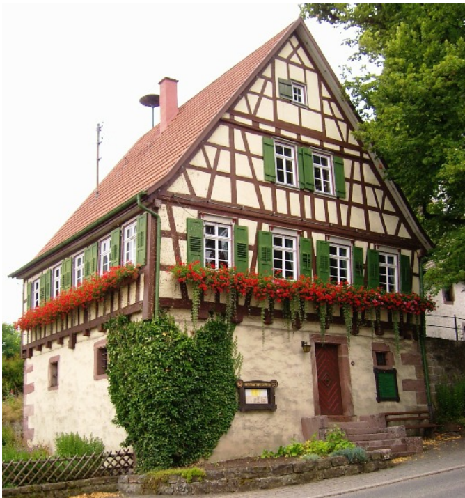
Heute ist dem das Heimatmuseum beherbergenden Alten Rathaus in Neuweiler neben der Kirche nicht mehr anzusehen, dass beim Einmarsch 1945 das Dach zerstört wurde.
