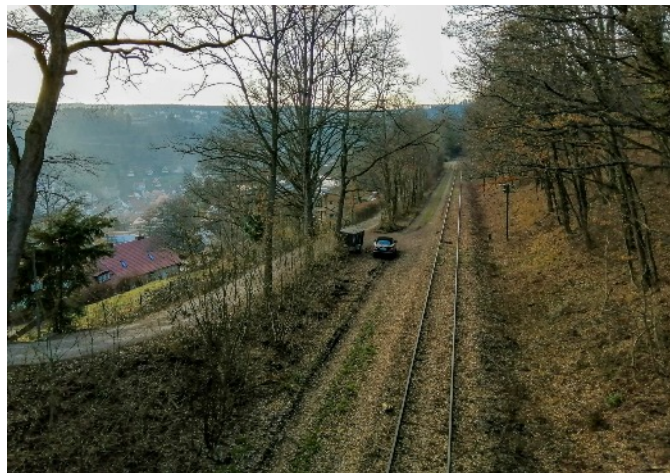
Auf dem Foto von der Hengstetter Steige, unterhalb von Heumaden in Richtung Stadtzentrum Calw, wird die ursprüngliche, in eine ausgesprengte Felsstufe eingefügte, zweispurige Bahntrasse erkennbar. Ab 1963 wurde der Verkehr nur noch einspurig betrieben. Luftbild: Matthias Kühn; weitere Fotos und Karte: Hagen Franke
