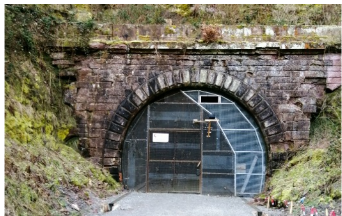
Der Hirsauer Tunnel, auch „Welzbergtunnel“ genannt
