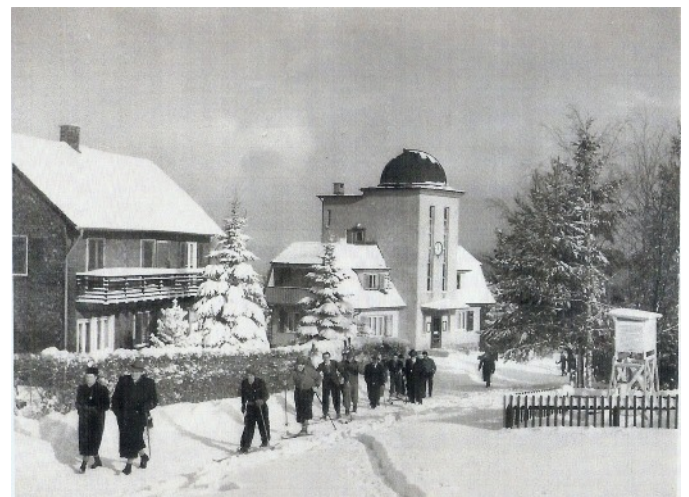
Wanderer und Wintersportler streben an der 1932 errichteten und bis 1961 als solche bestehenden Kepler-Sternwarte vorbei wohl nach Ankunft einer Sommerbergbahn auf die geplante Tour.
