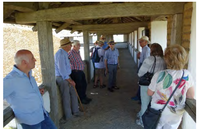
In verzapfter Holzbauweise und mit Holznägeln ist das Dach über der Schutzmauer der Heuneburg in der durch die Forschung ermittelten ursprünglichen Art nachgebaut.
