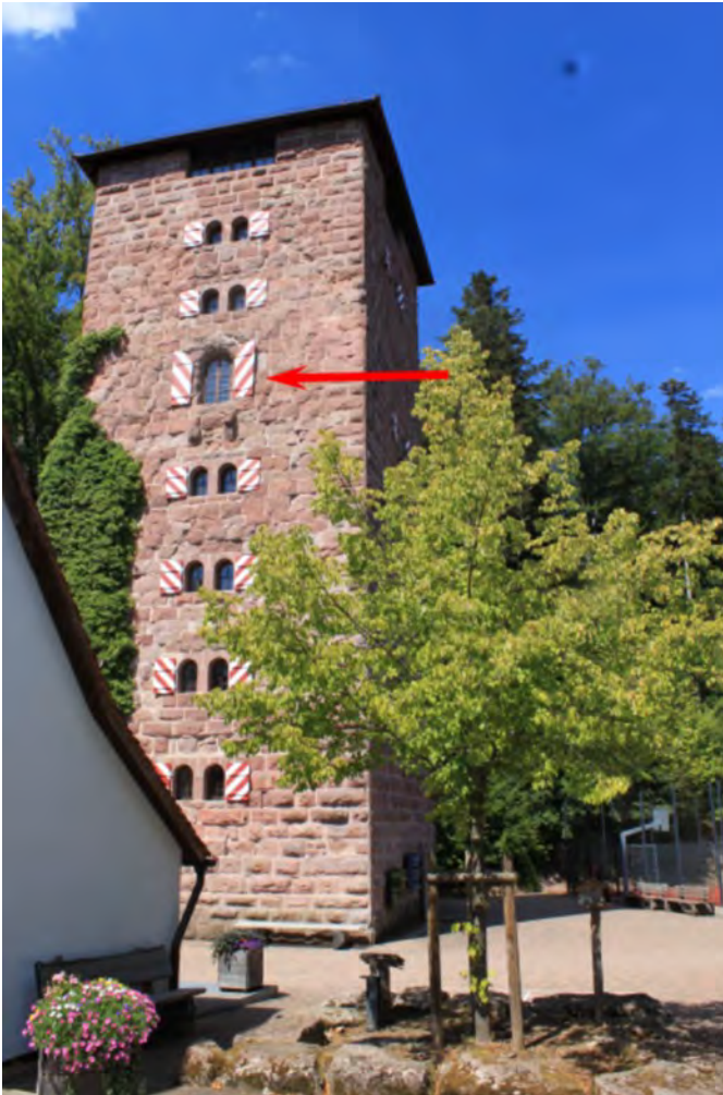
Der rote Pfeil zeigt am Turm der Burg Hornberg den Hocheingang im heutigen fünften Stock.
