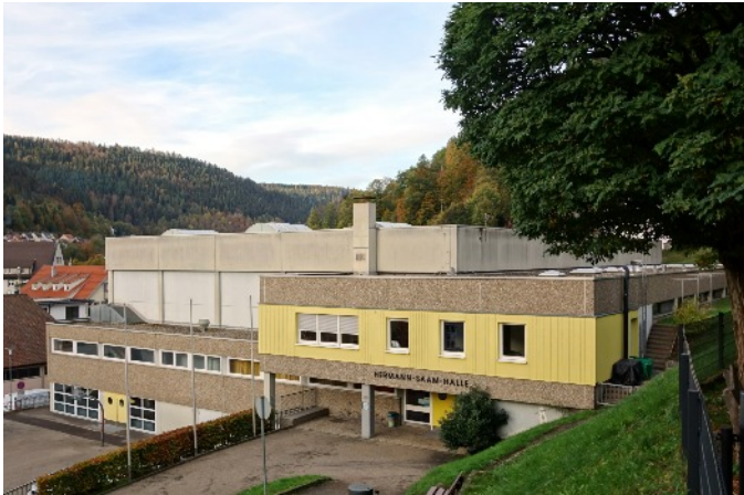
In der Bismarckstraße, ein Stück unterhalb der Wilhelmschule und von dieser aus über einen Fußweg erreichbar, steht die Hermann-Saam-Halle, die 1973/74 erbaut, bald ein halbes Jahrhundert alt wird.
